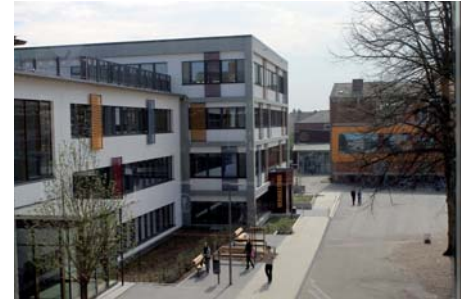
Blick von Westen auf das bereits sanierte Haus 3 und dem dahinterliegenden Neubau Haus 5.
