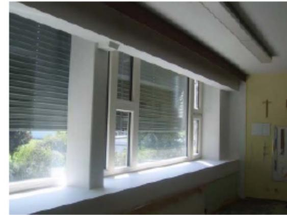
Neue Position der Fenster außerhalb der Stahlbetonträger
