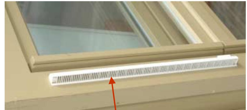
... von außen abgedeckt durch Wetterschutzgitter mit Insektenschutzfunktion
