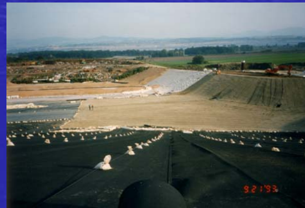
Basisabdichtung Deponie Radgendorf
